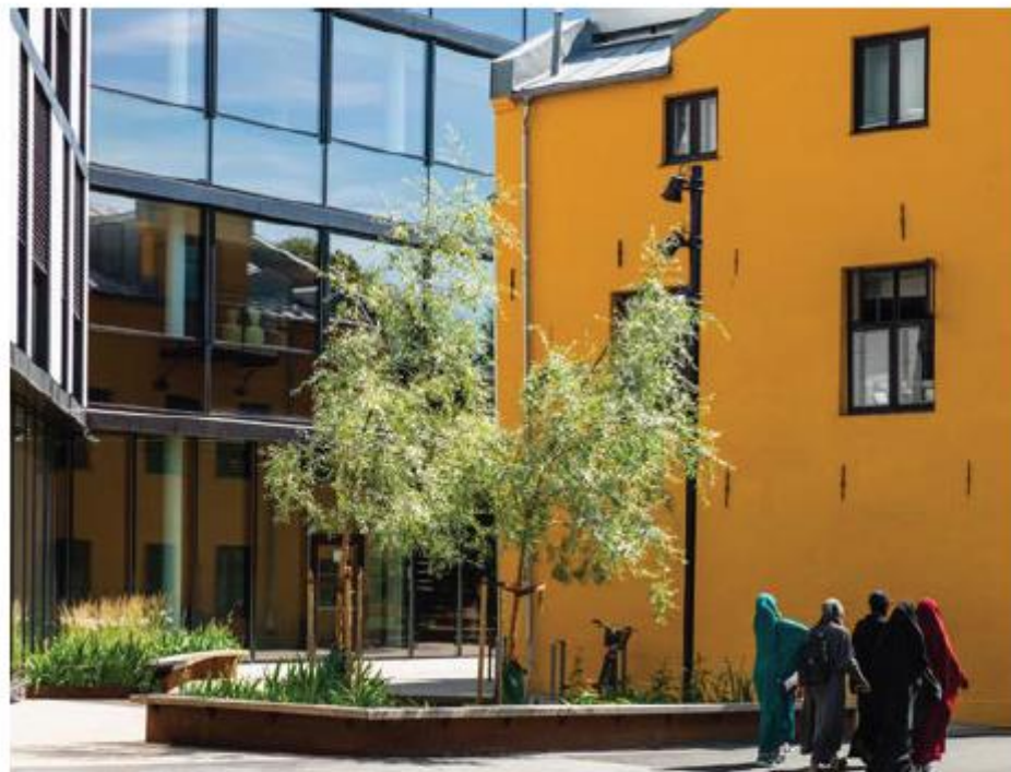
Illustrasjon 38: Sundtkvartalet, Oslo. To gamle industribygg og et gammelt kirkebygg er bevart og integrert i den nye bebyggelsen. (Kilde: Grindaker, foto: Damian Heinisch)
